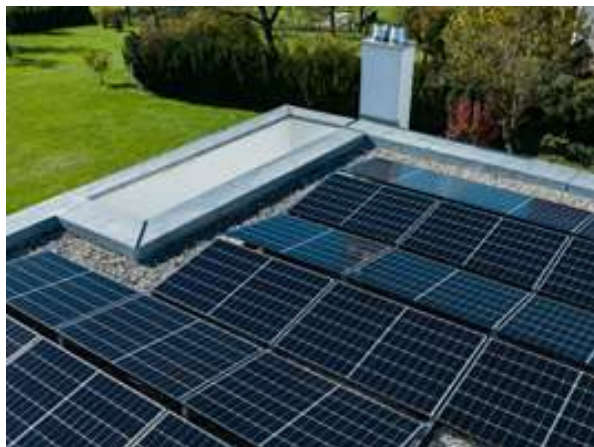
Рисунок 1.8 – Максимально можливе заповнення дахового простору сонячними панелями
