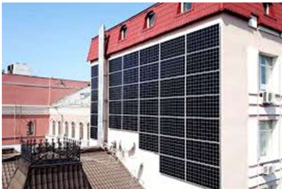
Рисунок 4.21 - Приклад використання фасадних поверхонь будівлі для СЕС
