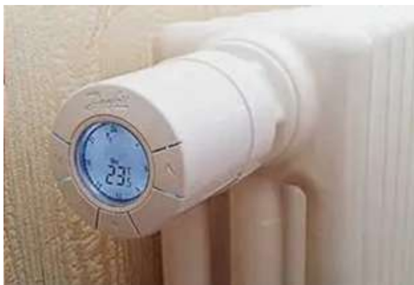
Рисунок 4.14 - Зовнішній вигляд автоматичного терморегулятора
