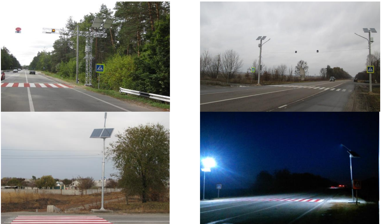
Фото. 6.1.5 - 6.1.8. Впровадження новітні технологій альтернативних джерел автономного освітлення наземних пішохідних переходів на автомобільних дорогах загального користування
