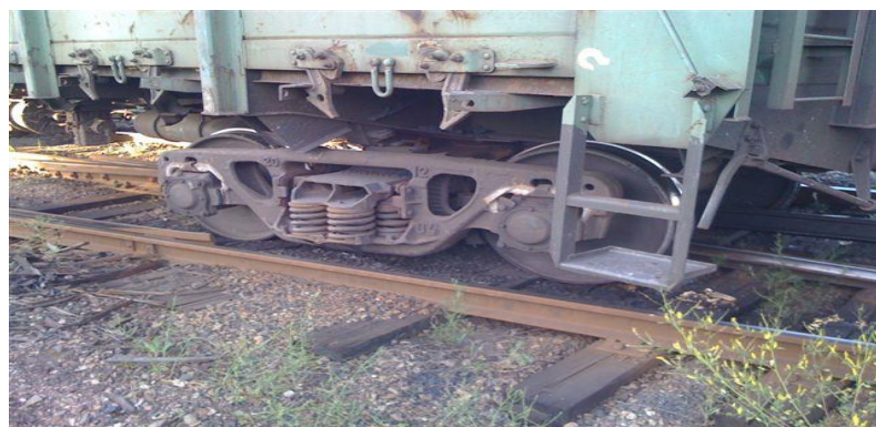
Фото. 5.3.2.5. Транспортна подія, яка сталася 10.06.2015 на Енергодарській філії на стрілочному переводі № 19, де при виконанні маневрових робіт локомотивом ТГМ-6А № 2107 з 16-ма вагонами завантаженими вугіллям, стався схід 7-го вагону двома колісними парами другого візка та 6-го вагону двома колісними парами першого візка за напрямком руху
