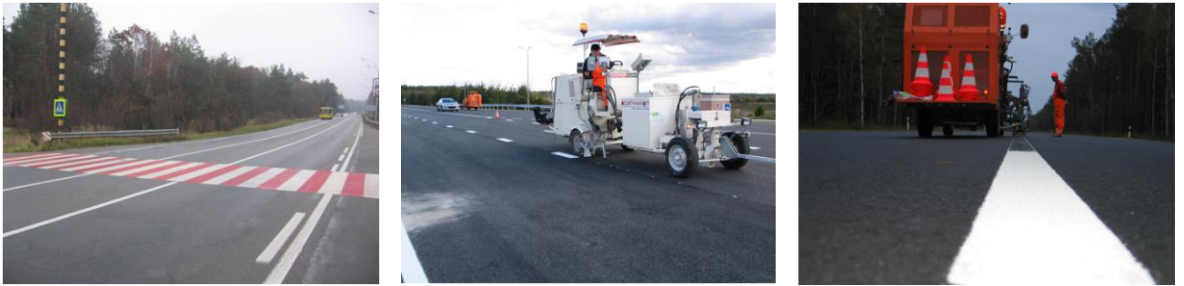
Фото. 6.1.3 - 6.1.4. Нанесення дорожньої розмітки на проїзну частину автомобільної дороги
