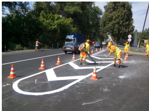
Фото 38. Нанесення розмітки на проїзну частину
