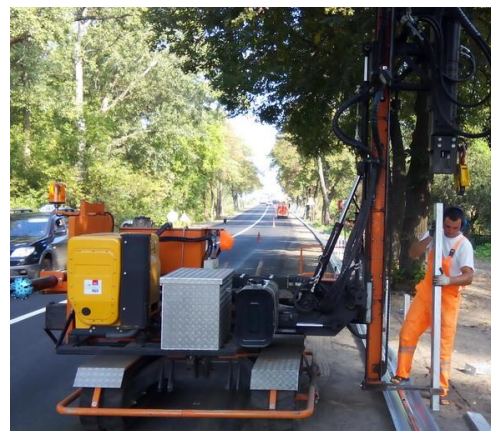
Фото 36. Встановлення бар'єрного огородження
