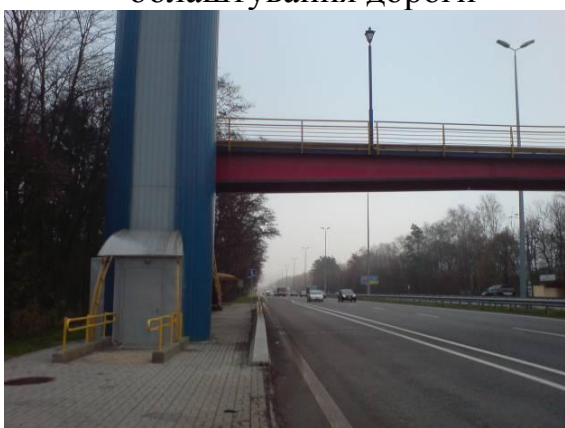
Фото 39. Встановлений ліфт для маломобільних груп населення
