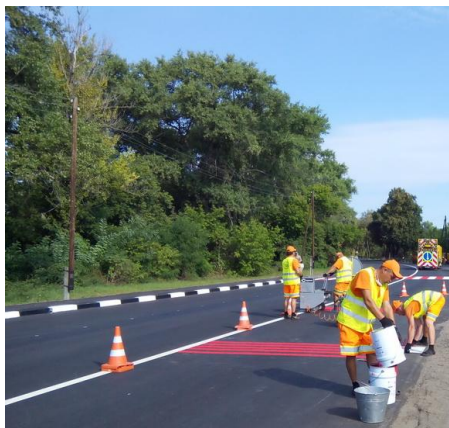
Фото 37. Нанесення розмітки та облаштування дороги
