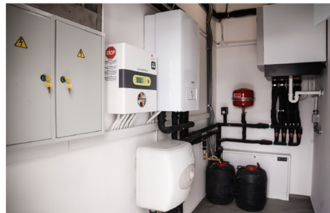
Система теплового насосу "повітря/вода"
