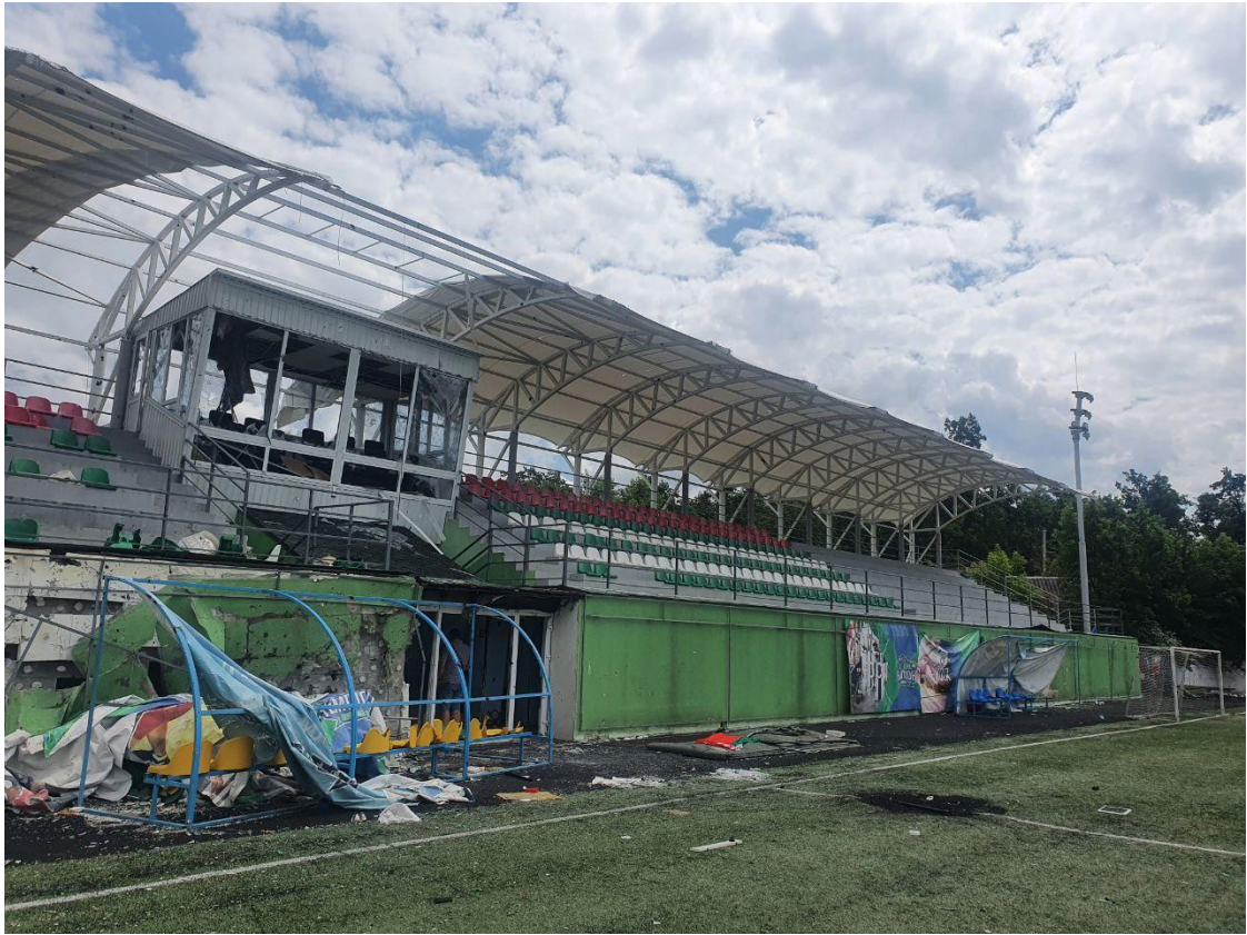
Фото 2.2 – будівля трибуни (з боку футбольного поля)
