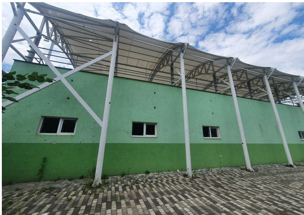
Фото 2.1 – фасад будівлі трибуни
