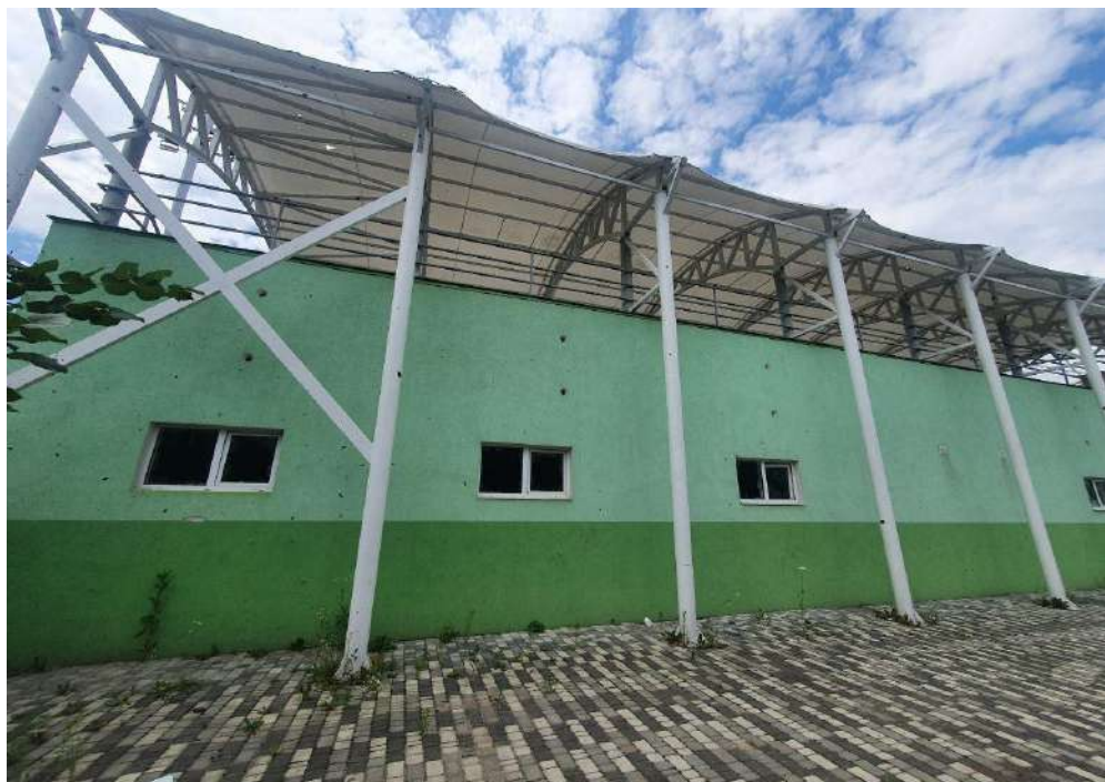
Фото 2.1 – фасад будівлі трибуни
