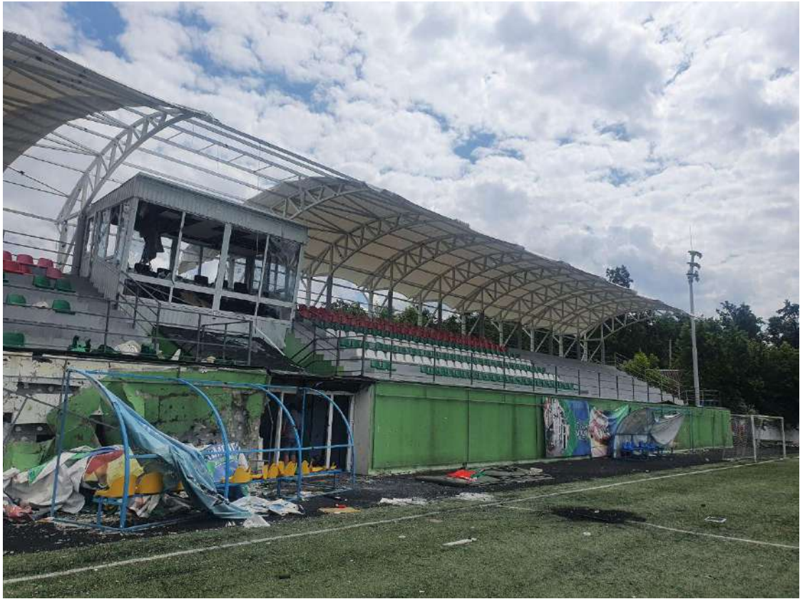
Фото 2.2 – будівля трибуни (з боку футбольного поля)
